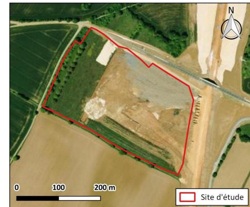
Figure 19 : Photographie aérienne du site en 2014 pendant le chantier de la LGV SEA (Source : IGN)
