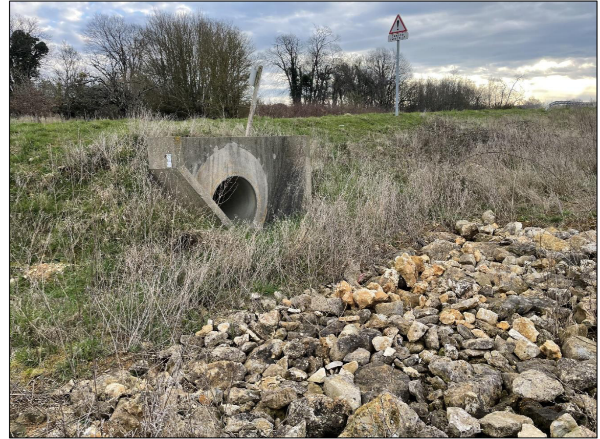
Prise de vue B : Vue sur une buse d'évacuation d'eaux pluviales depuis le nord du site d'étude en direction du nord
